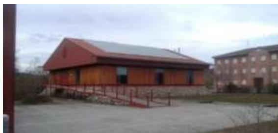
Imagen 53. Vista del edificio de la Oficina de Empleo de Sabiñánigo
