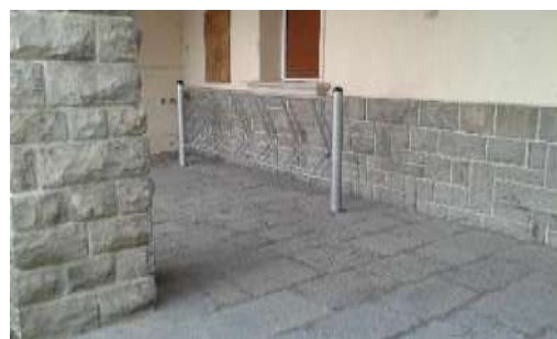
Imagen 60. Vista del aparcamiento de bicicletas instalado en Pza. España
