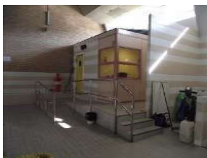
Imagen 41. Acceso a la zona de baño en Piscina climatizada
