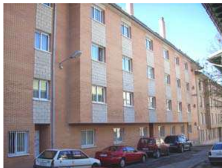
Imagen 14. Exterior de la Residencia para mayores Valles Altos
