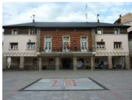
Imagen 54. Vista del edificio de la Oficina de Empleo de Sabiñánigo
