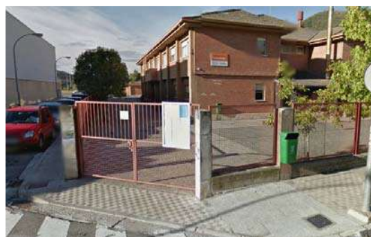
Imagen 19. Colegio Puente Sardas. Acceso desde la C/ Derechos Humanos
