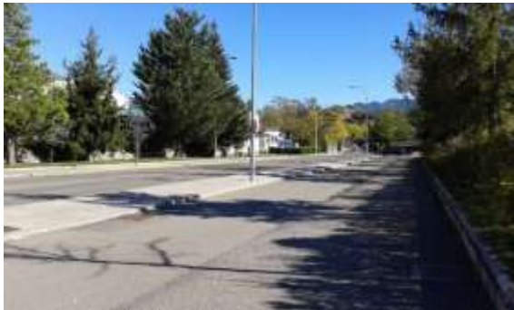
Imagen del estado actual de Avda. Huesca en el tramo paralelo a las fábricas
