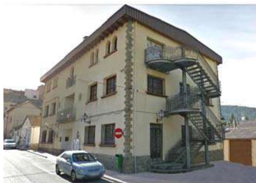
Imagen 28. Imagen del edificio Centro Sociocultural Puente Sardas
