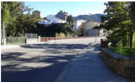
Imagen del estado actual del Puente sobre el Río Gállego
