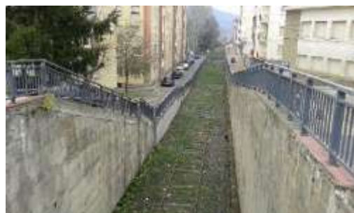
Imagen 3. Ramal ferroviario de la fábrica Ercros
