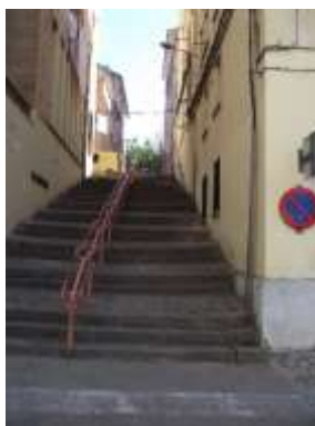
Imagen del tramo de escaleras entre C/ Luis Buñuel y C/ Coli Escalona
